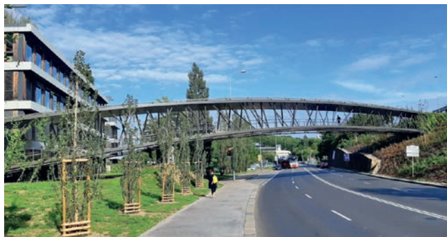
EXCON spojuje... Jako v případě stávající a nové budovy ČSOB v Praze
